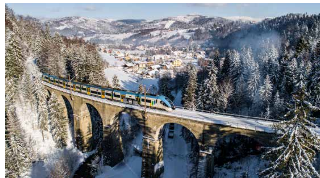
Wiadukt kolejowy w Łabajowie / Railway Viaduct in Łabajów
