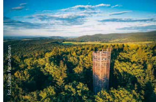
Wieża widokowa na Łysuli / Aussichtsturm auf dem Łysula
