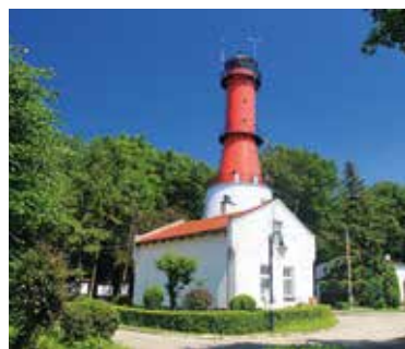
Latarnia morska w Rozewiu
