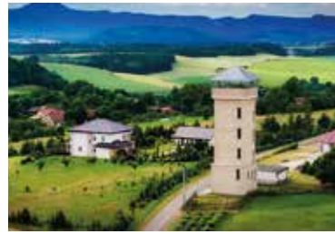
Wieża widokowa w Suszynie
