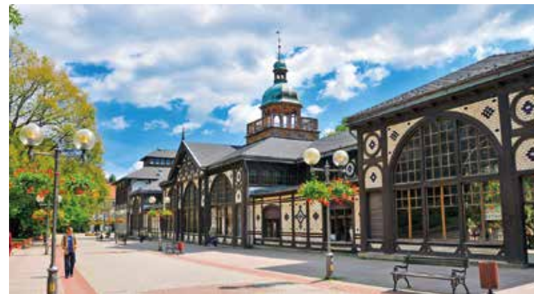
Szczawno-Zdrój – pijalnia wód mineralnych i hala spacerowa
