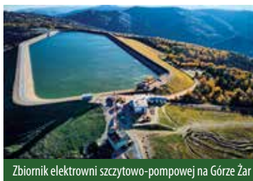
Zbiornik elektrowni szczytowo-pompowej na Górze Żar
